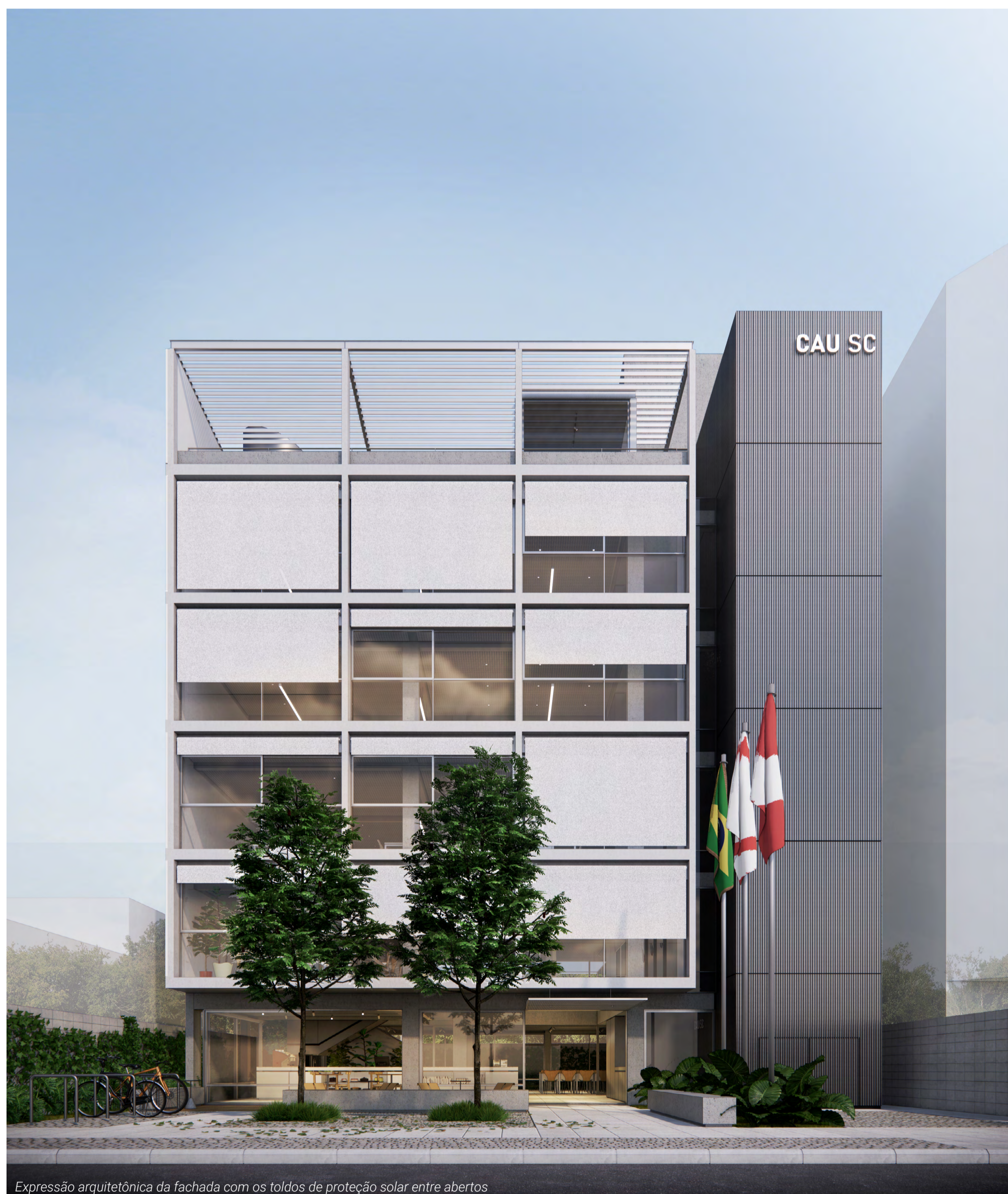
Expressão arquitetônica da fachada com os toldos de proteção solar entre abertos
