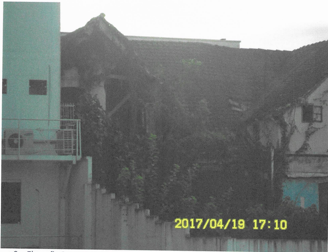
Figura 9 – Elevação Posterior, em seu estado atual, evidenciando uma área tomada pela vegetação, em consequência do abandono e falta de conservação.(Fonte: Arquivo da Fundação Catarinense de Cultura- FCC)
