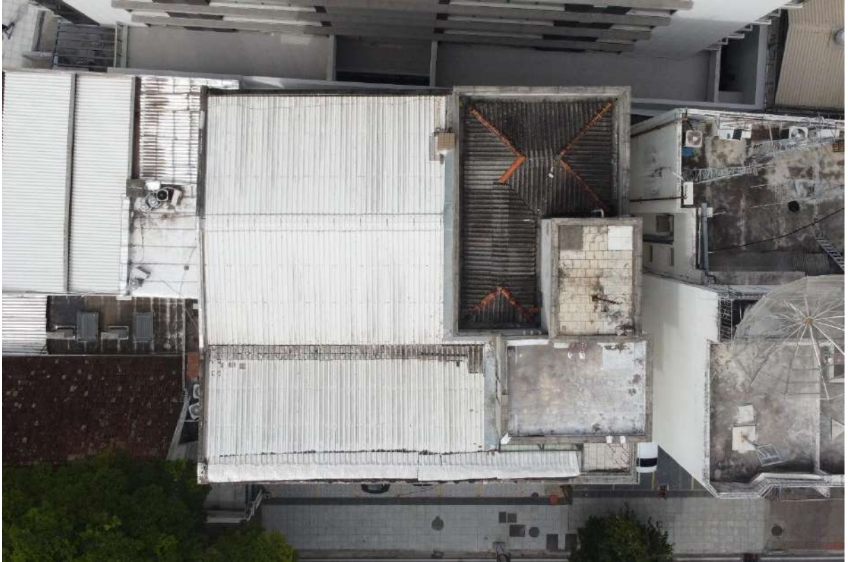
Figura 3 - Vista da cobertura da edificação.
