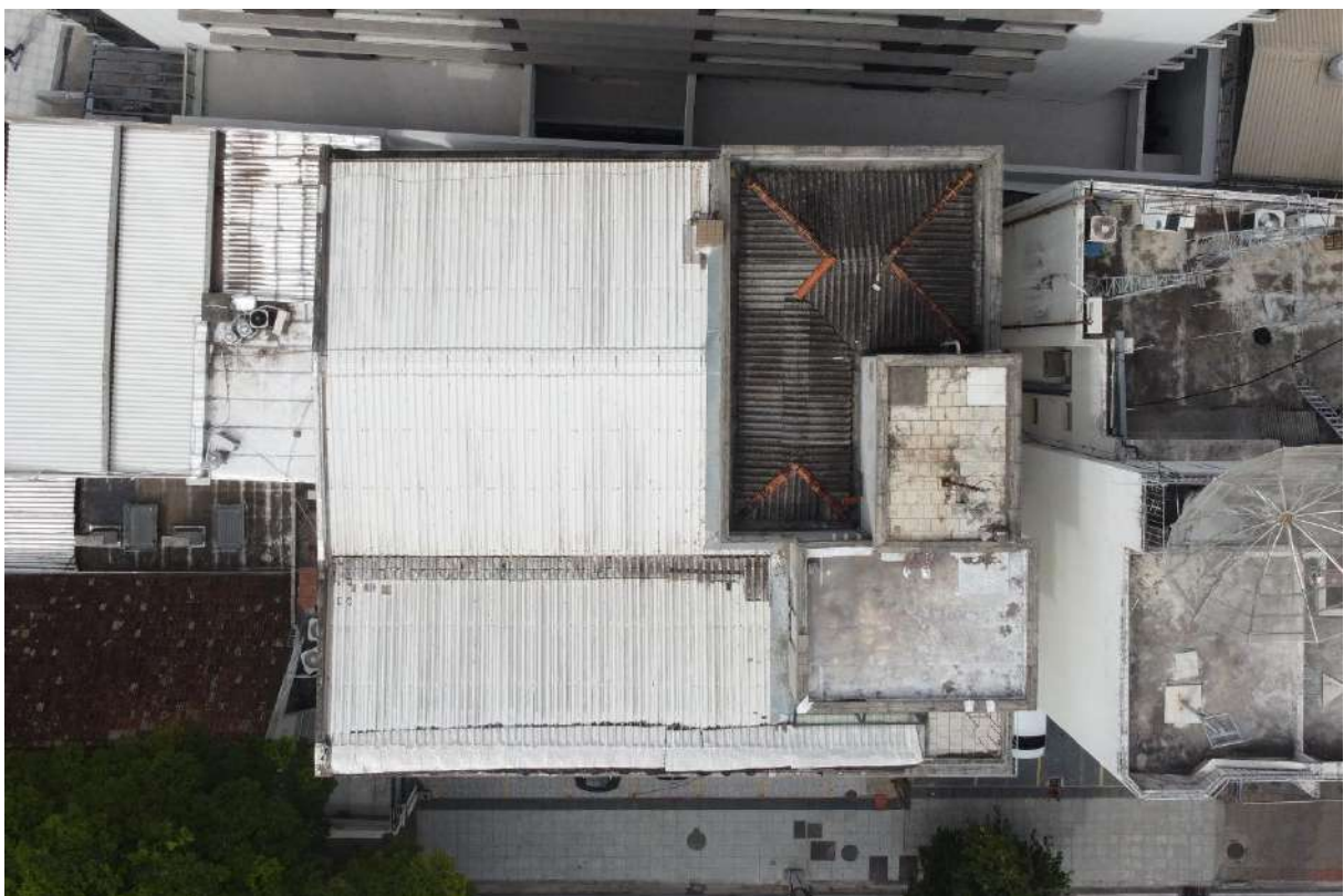
Figura 3 - Vista da cobertura da edificação.
