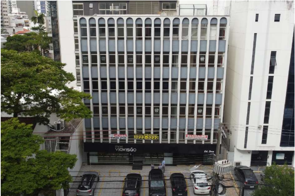
Figura 2 - Fachada frontal do imóvel objeto de estudo.
