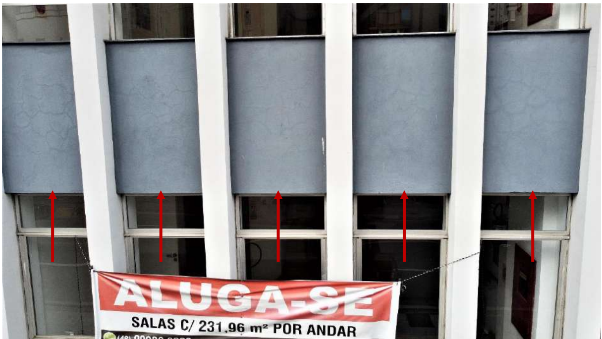
Figura 8 – Fissuras mapeadas por toda a extensão da fachada norte.
